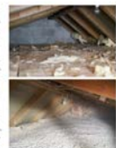
Abbildung 1: Dämmung der obersten Geschossdecke mit Kernemitt aus Glaswolle (links) und mit Zellulosefasern (rechts).
