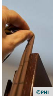
Dichtung ankleben
