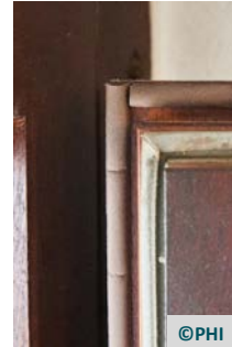
In den Ecken stumpf stoßen
