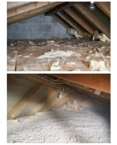
Abbildung 1: Dämmung der obersten Geschossdecke mit Klemmfilz aus Glaswolle (oben) und mit Zelluloseflocken (unten).
