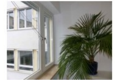
Abbildung 1: Fertige Laibungsdämmung. Es ist nichts zu sehen. So soll es auch sein.
