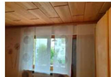
Abbildung 1: Ausgangssituation – Der Kasten enthält einen Rollladen für das Fenster und einen für die Türe.
